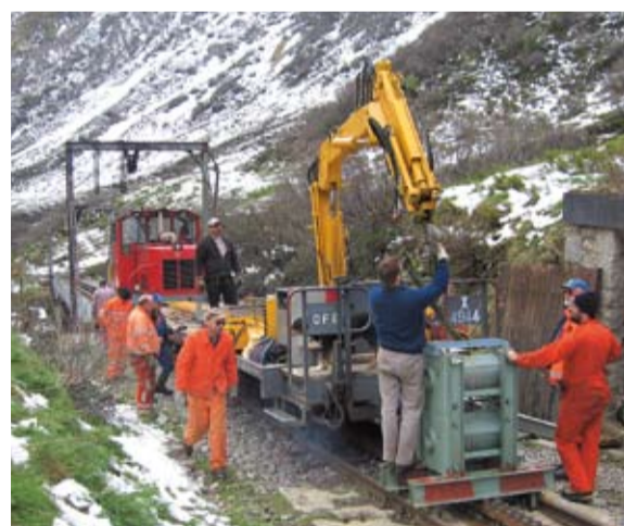
Rotzler HK 075-Seilwinden beim Abbau der Steffenbachbrücke
