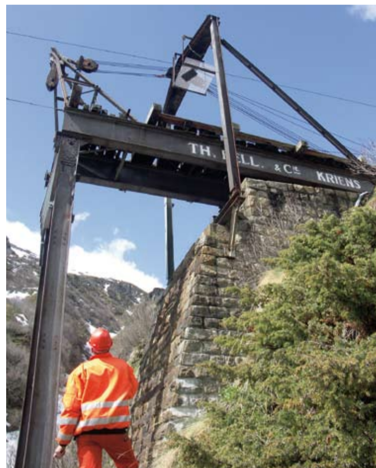
Abgesenktes Brückenmittelteil der Steffenbachbrücke
