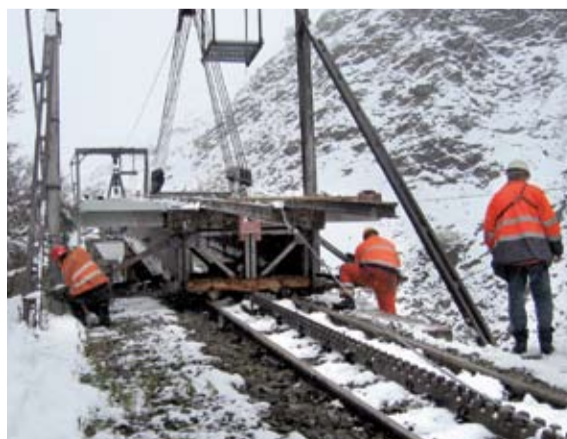
Die HK-Winden werden zum Auf- und Abbau auf die Schienen positioniert (Bild links) und ziehen die tonnenschweren Brückenteile in die gewünschte Stellung (Bild rechts)
